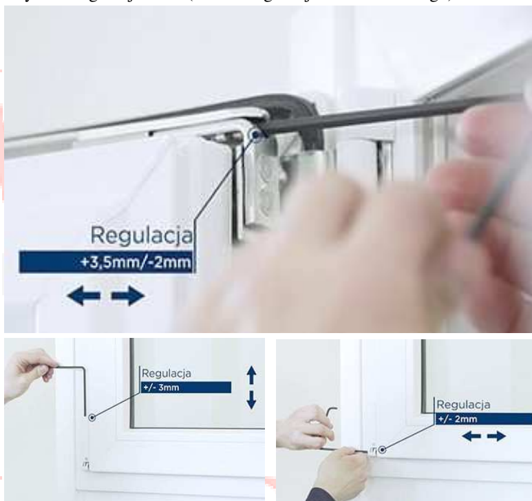
Rys. 2. Regulacja okuć (rozwórki górnej i zawiasu dolnego).
